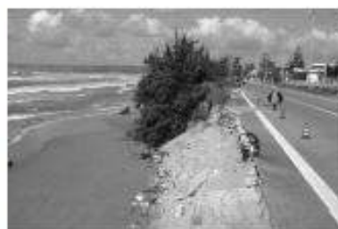
Erosione costiera a S. Maria del Foccolo
